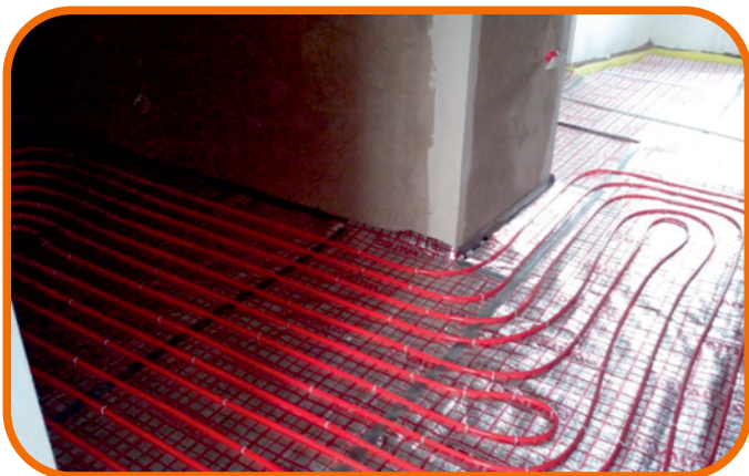
Система тёплого пола с заливкой стяжки
