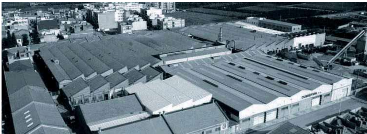
ЗАВОД ARCO (ВАЛЕНСИЯ – ИСПАНИЯ)
