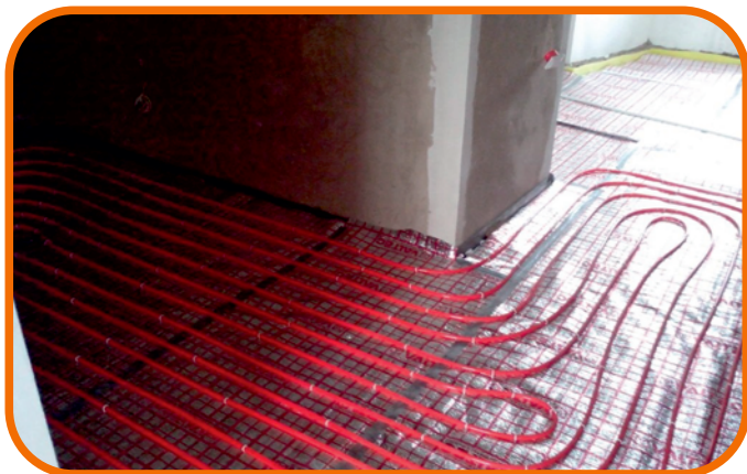
Система тёплого пола с заливкой стяжки
