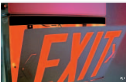
292 Во избежание рассеяния светового потока по периметру знака, плотно фиксируйте клейкую виниловую ленту на вспененной основе ЗМ™ серии 4726
